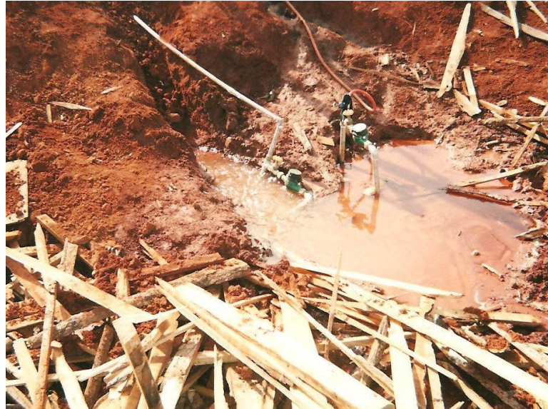
Figura 4: Torneiras para uso coletivo do Assentamento
