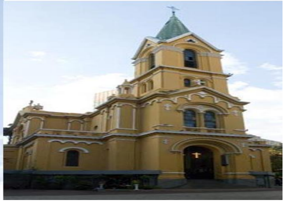
FIG.:18 Frontal da Capela, entrada dos fiéis
