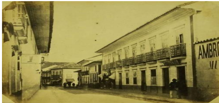
FIG.:4 Casas baixas e sobrados de taipa de pilão, ano 1862, Rua Direita.
