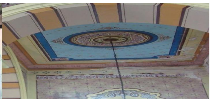
FIG.:26 Parede superior lado esquerdo frontal da Capela
